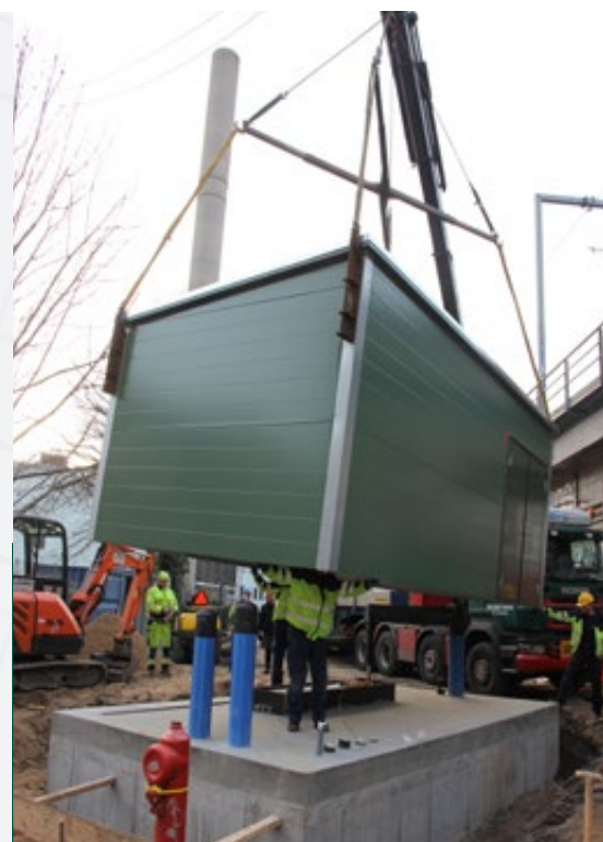
Frederiksberg Forsyning har fået 1 ny trykforøgerstation, hvilket har forbedret forsyningsikkerheden med 20 %. Fundament og bygning var på plads i december 2019. Her er bygningen på vej mod sin endelige destination oven på fundamentet. Trykforøgeren i bygningen har en kapacitet på 300 m³/t.
