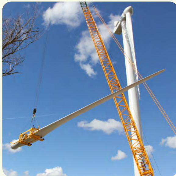
Frederiksberg Forsynings vindmøller ved St. Røttinge i Næstved Kommune var klar til produktion i juni 2015. Her er en vinge ved at blive hejst på plads. Den er 57,5 m lang og vejer 14 tons.
